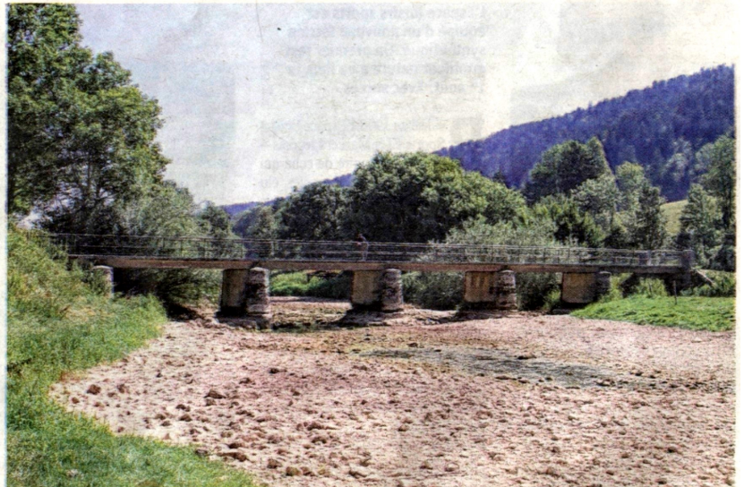
À Montbenoit, l'eau ne coule plus sous les ponts et de nombreux poissons morts jonchent le sol. Photo V.C.
