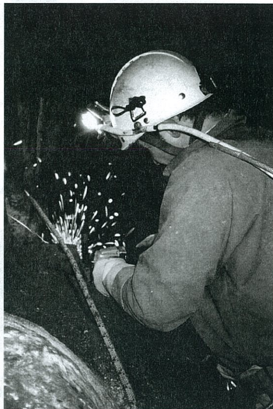
Démontage des Agrès en Place
