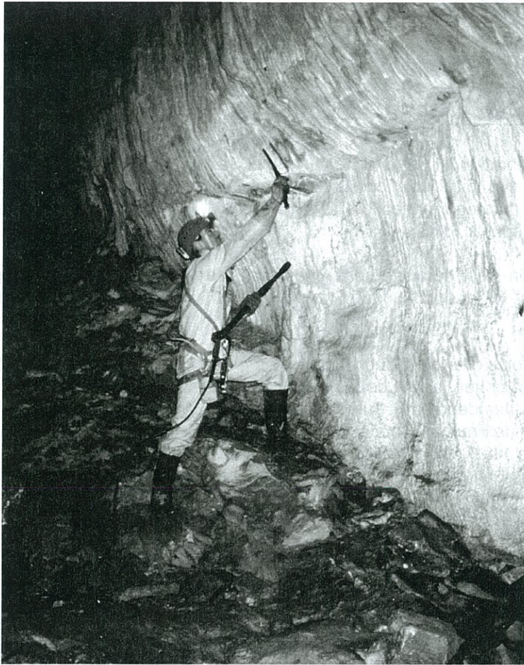
Nettoyage des graffiti au hacher
