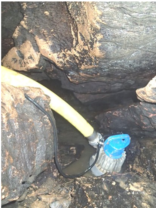
Pompe de 30 m 3 /h dans le siphon
