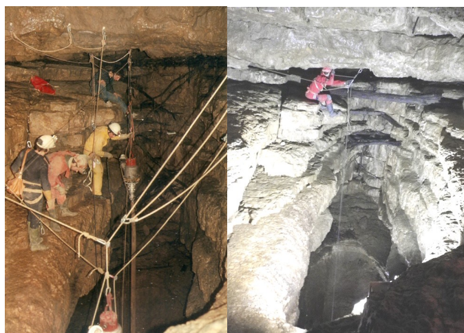
Installation de pompes dans le Puits Fenoz dans les années 1990 et l'éclairage en 2013. Photo : J-M Frossard et C Perrot
